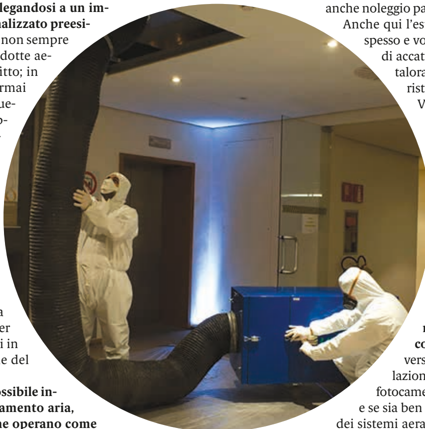
UNA SQUADRA TECNICA ATTENDE ALLA MANUTENZIONE DI UN IMPIANTO AERAUICO
